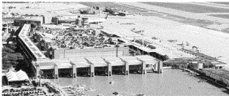
Anello di congiunzione tra l'aria e l'acqua. Il nuovo terminal sull'acqua dell'aeroporto di Venezia (Water Terminal) inaugurato a novembre. L'opera ha richiesto un investimento di 33 milioni
