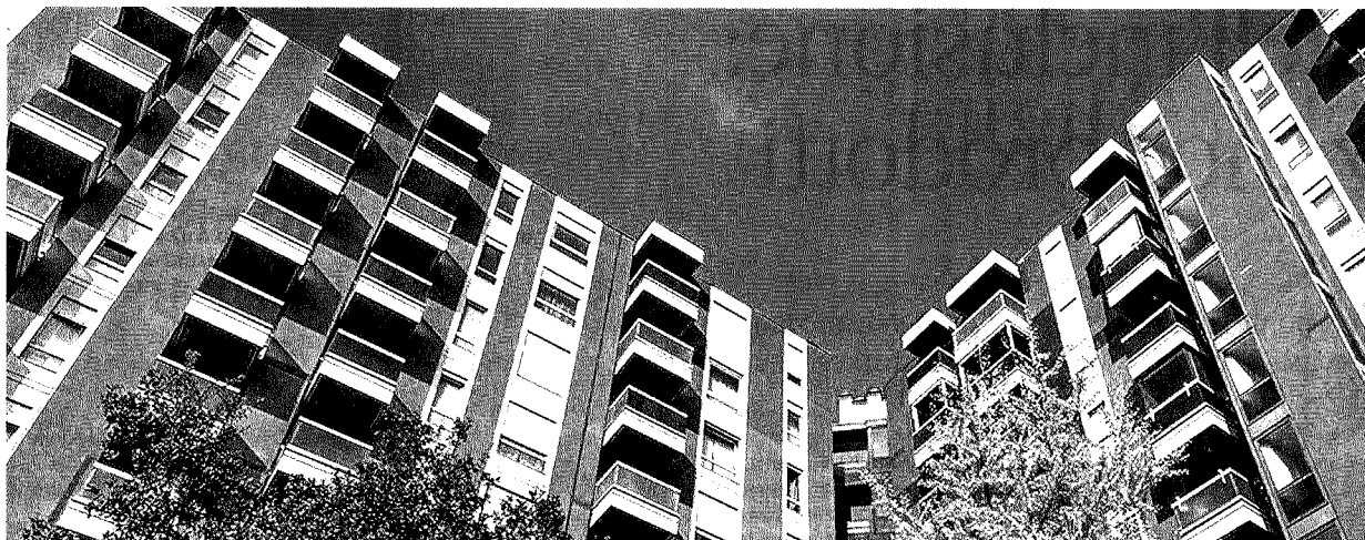
Torino. Il condominio Teodosia, tra le prime applicazioni del protocollo Gbc condomini, sistema di rating a supporto di chi vuole un risultato ottimale.
