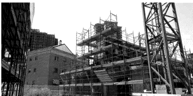
Casa in costruzione
