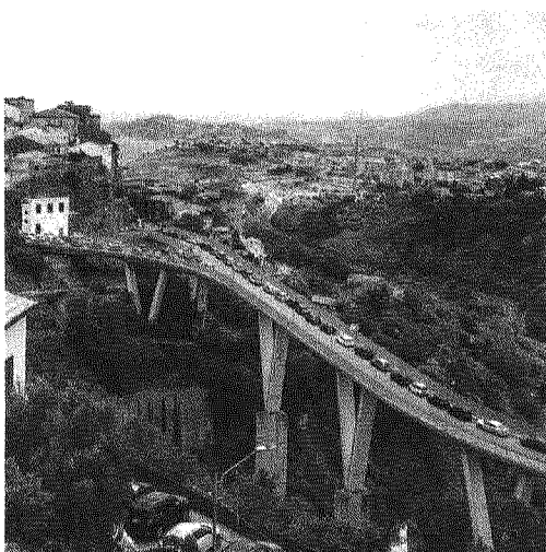
Viadotto Il «Bisantis» costruito da Riccardo Morandi (lpp)
